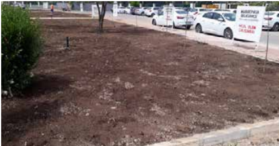
Güzeloba Mahallesi 2156 Sok. Park Turunç Dikim Çalışmaları
