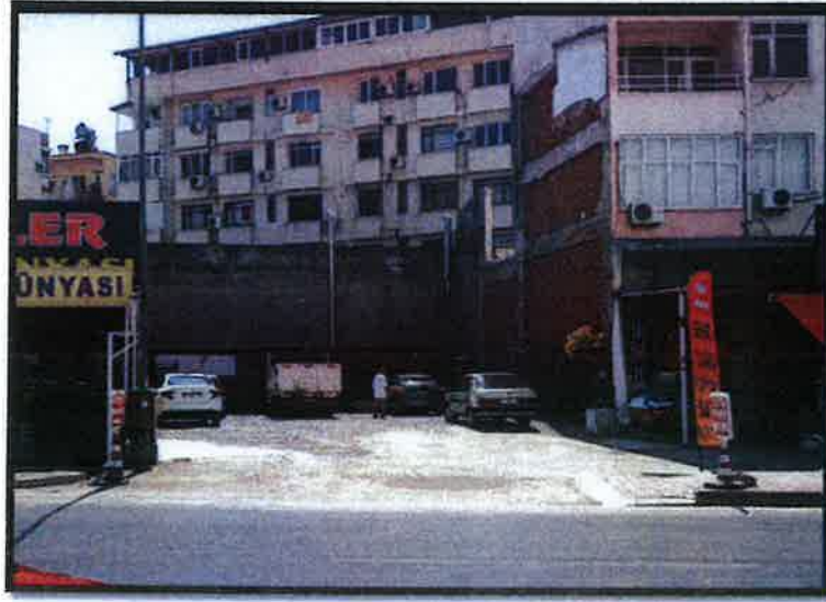
Parselin Üzerindeki Yıkılan Yapı ve Mevcut Durumu
