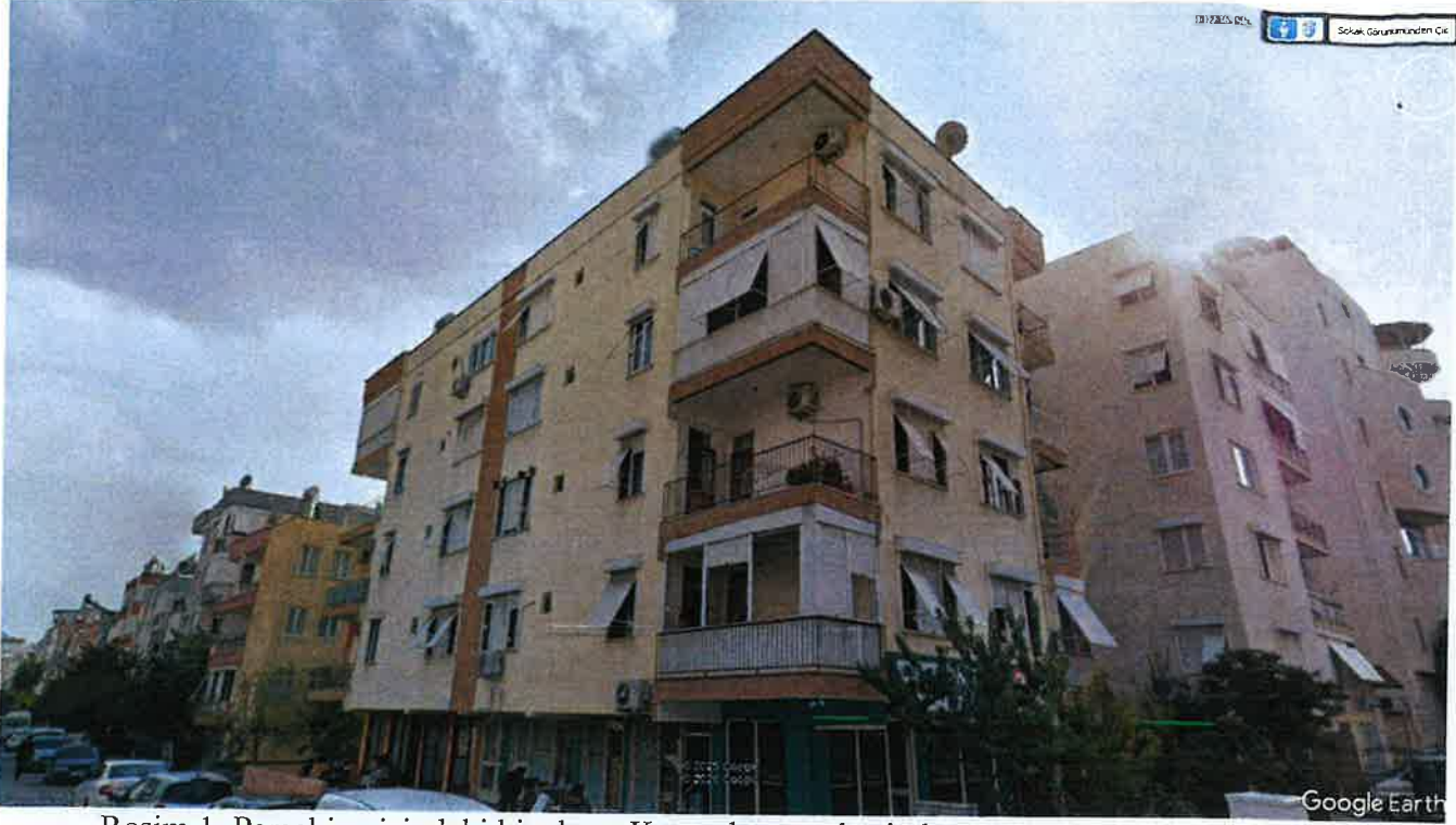
Resim 1. Parsel içerisindeki binaların Kuzey batı cephesinden görünüşü
