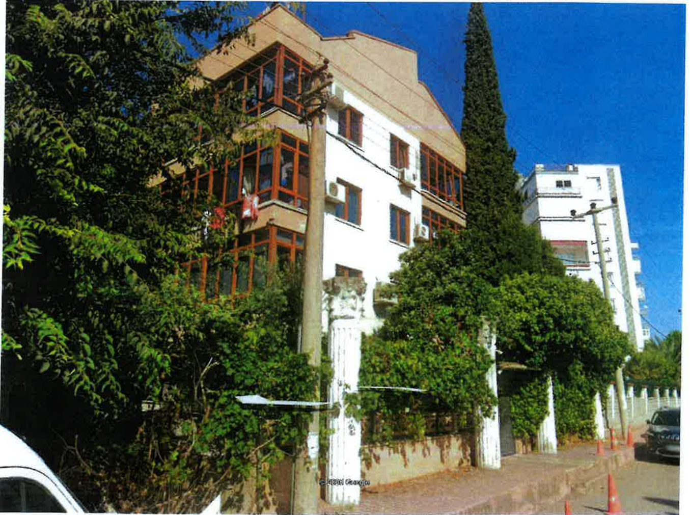
Resim 2. Parsel içerisindeki binanın Güney doğu cepheden görünüşü
