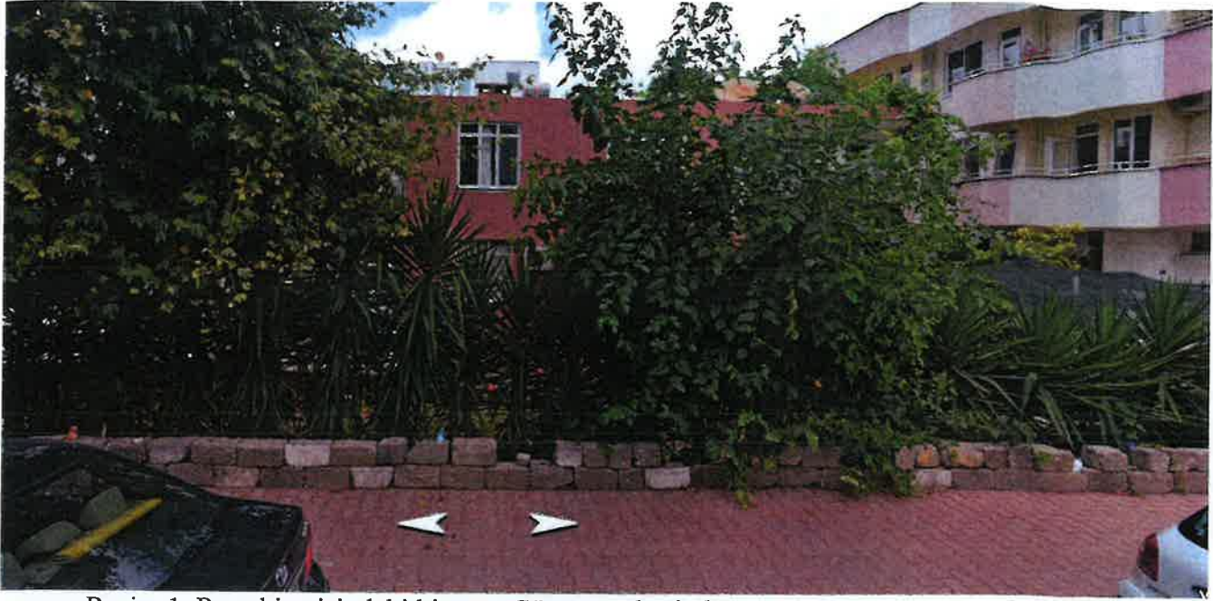
Resim 1. Parsel içerisindeki binanın Güney cephesinden görünüş
